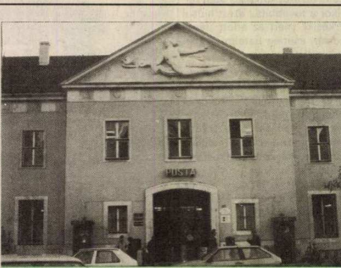
Ismét találtunk egy szocreál remekművet. Győr 2 postahivatal homlokzata.
